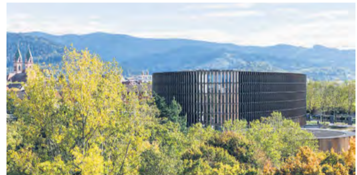
Das Rathaus der Stadt Freiburg erzeugt mehr Energie als es verbraucht. Foto: HG Esch
