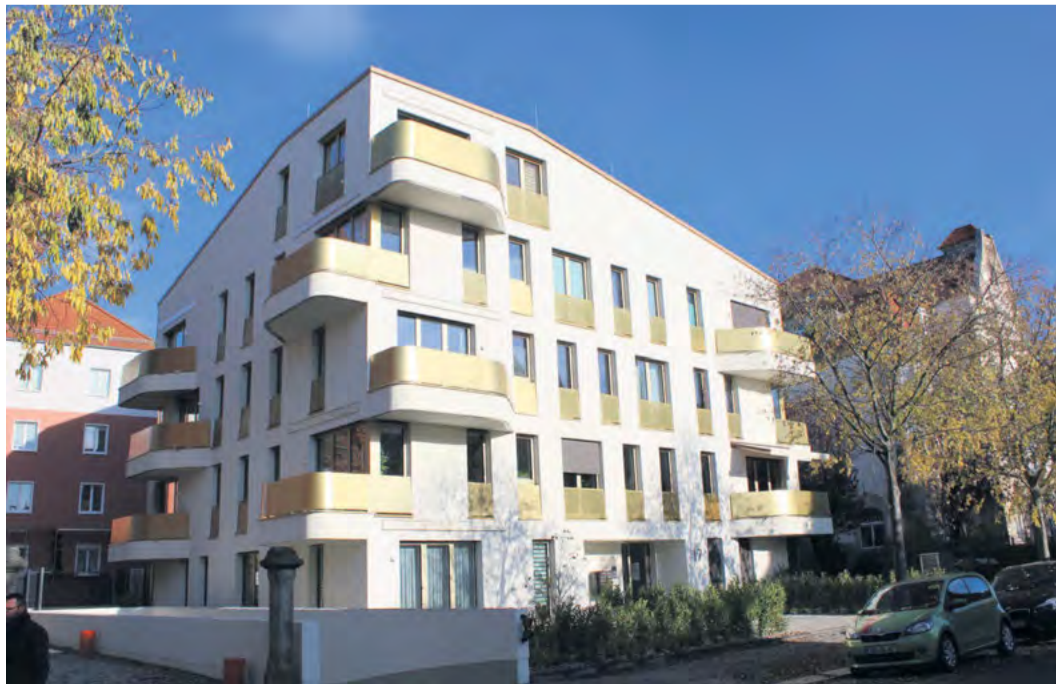
Das erste Zukunftshaus in Dresden steht in der Haydnstraße 17.
