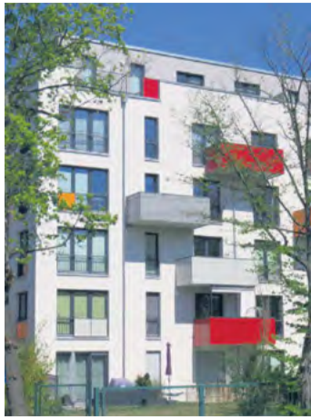
Rund 11 Millionen Euro hat die Vonovia in zwei Neubauten an der Stübellee investiert. Foto: Pohl
