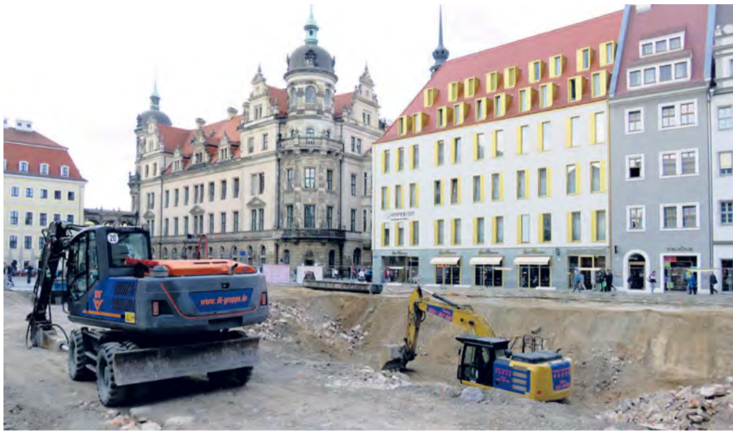
Anfang April fiel der Startschuss für die Bebauung des letzten freien Quartiers auf dem Neumarkt. An der Schloßstraße baut die Baywobau das „Schloßbeck“ – bestehend aus fünf Gebäuden. Als Leitbauten sollen das Caesarsche Haus und das Fürstliche Haus wiederentstehen. Foto: Pohl
