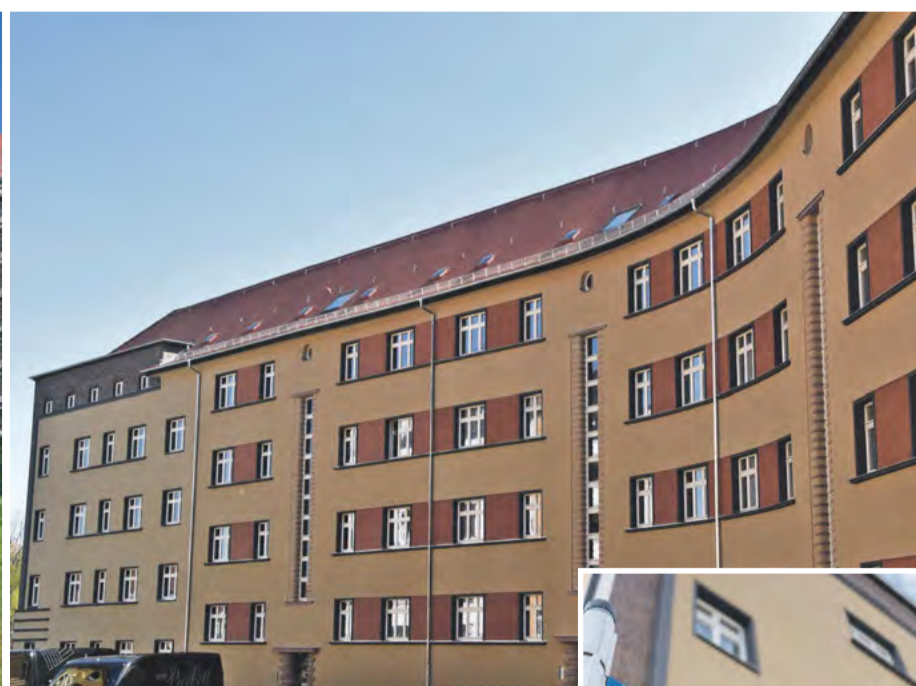
Blick auf die Wohnanlage Otto-Adam-Straße
