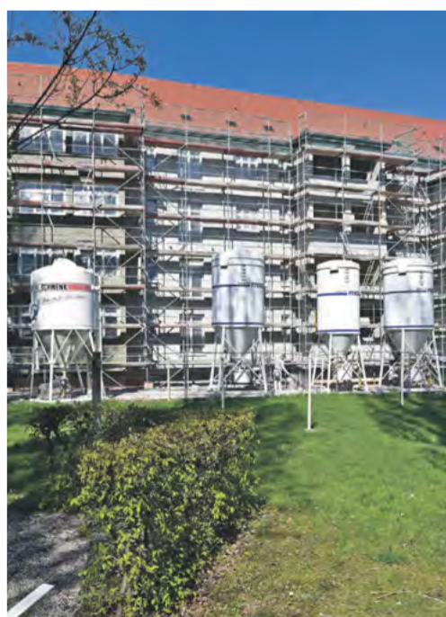
Noch ist der grüne Innenhof eine Baustelle. Der Anbau der Loggien und Balkone ist in vollem Gange.
